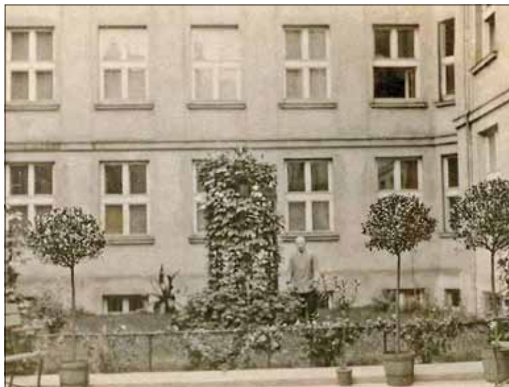
Ogródek na dziedzińcu kamienicy przy Chmielnej 4
